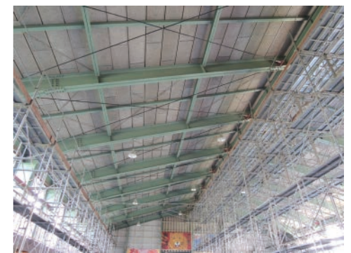
足場の設置状況（屋根、長尺配置）
