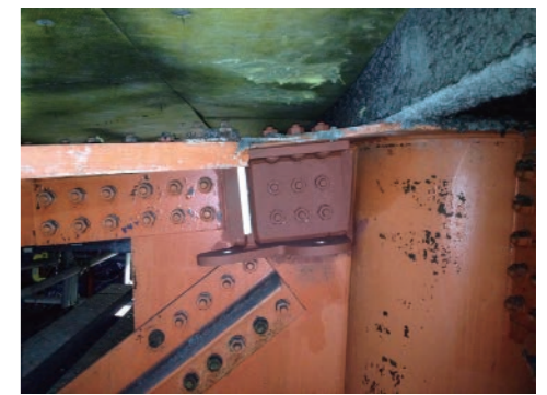
トラス梁への適用事例（屋根）
