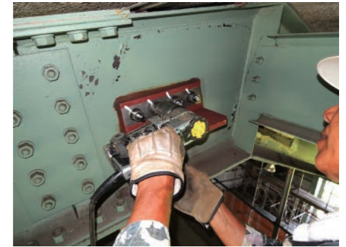
定着金具の取付（屋根）
