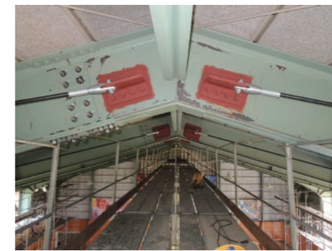
梁頂部の定着金具（屋根）
