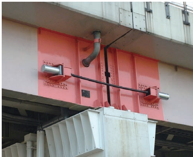
鋼製桁-鋼製桁連結（支圧型）
