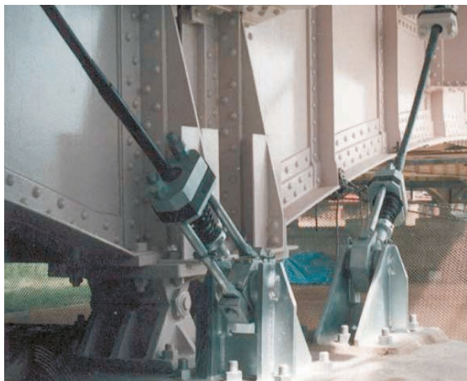
鋼製桁-下部工連結（ピン型）
