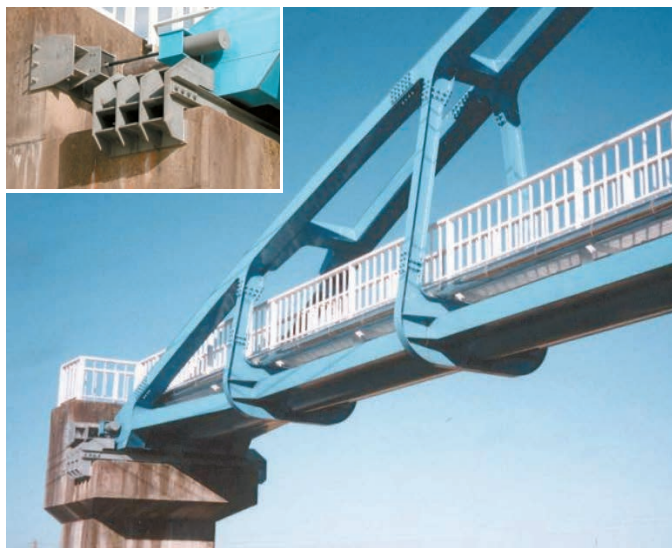
水管橋 鋼製桁-下部工連結（支圧型）
