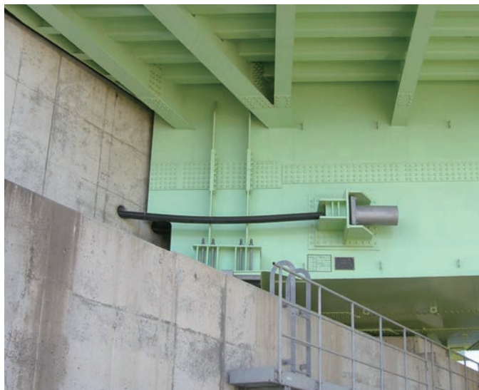
鋼製桁-下部工連結（支圧型）
