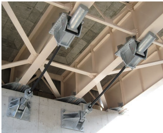
鋼製桁-下部工連結（支圧型／SPJ）
