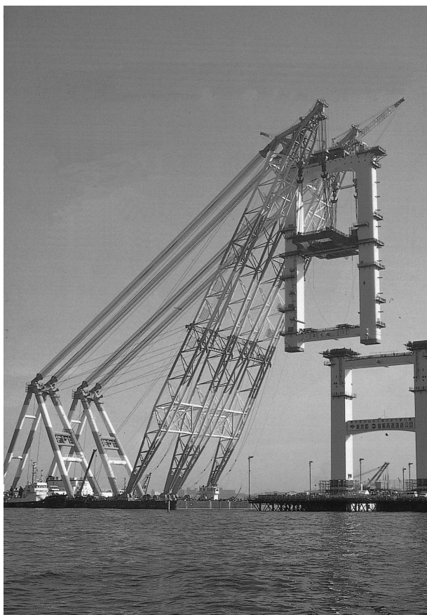
東京港連絡橋主塔架設工事に従事する 4, 100tつりフローティングクレーン
