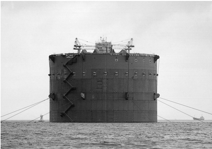
明石海峡大橋主塔用鋼ケーソンを係留するデルタフィラー®ロープ120mm
