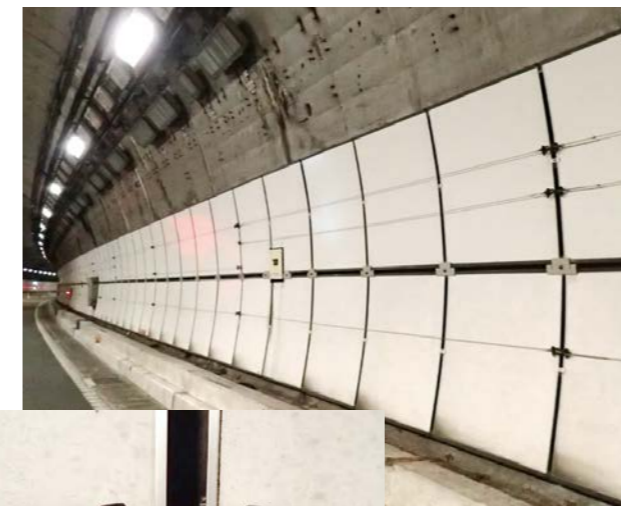
トンネル内装板落下対策
