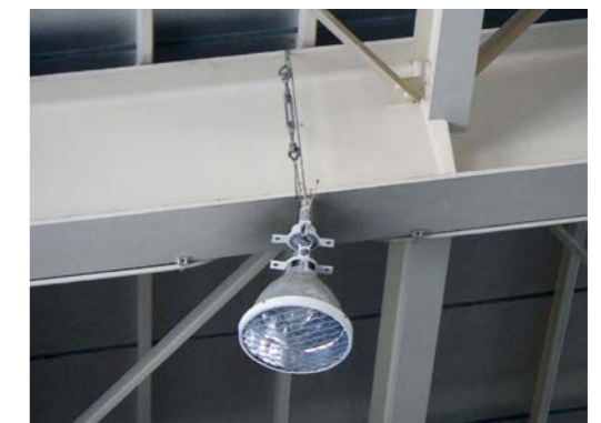
体育館天井照明落下対策
