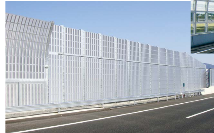
遮音壁落下防止装置
