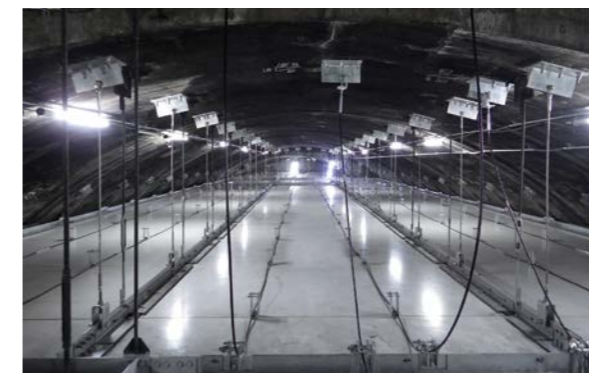
トンネル天井板落下対策
