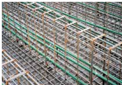
主ケーブルの配線状況 Wiring state of main cables
