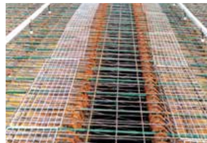
横締めケーブルの配線状況 Wiring state of lateral fastening cables
