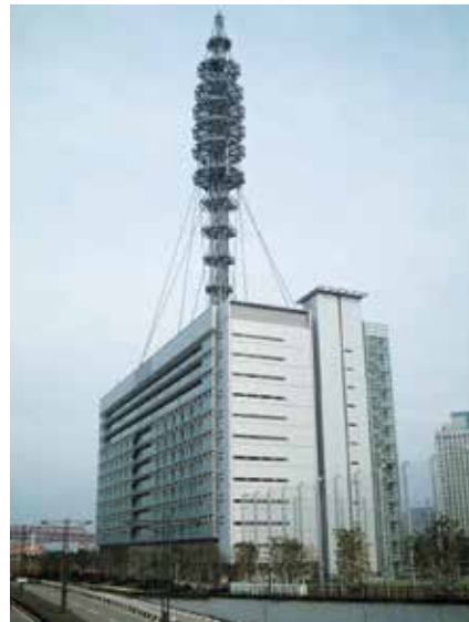
ドコモ大阪第二ビル(大阪市住之江区) DoCoMo Osaka Building 2 (Osaka)
