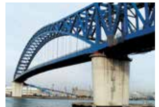
千歳橋(大阪市大正区) Chitose Bridge (Osaka)
