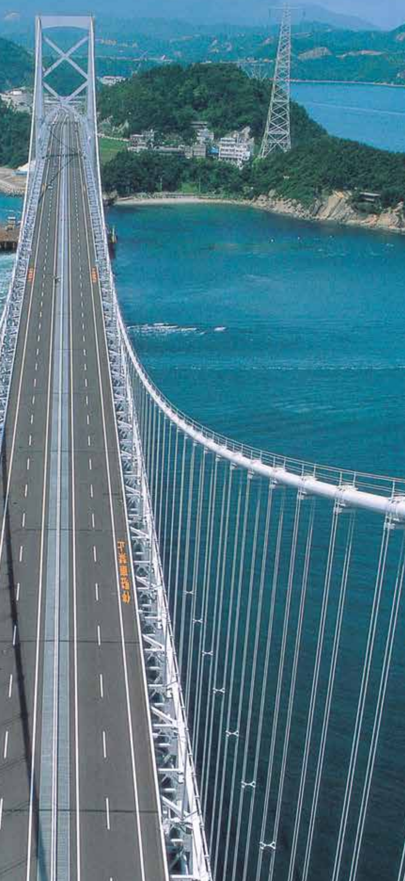
◆表紙：瀬戸大橋(児島・坂出ルート) Onaruto Bridge Cover: Seto-Ohashi Bridge (Kojima-Sakaide Route)
