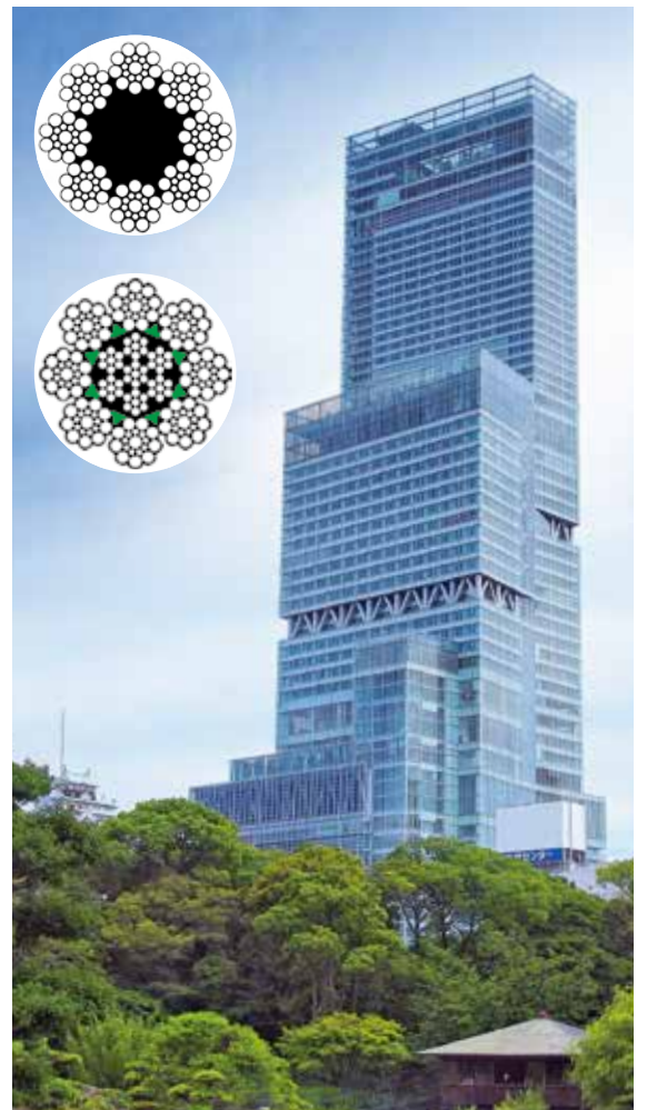
エレベータ Elevator
