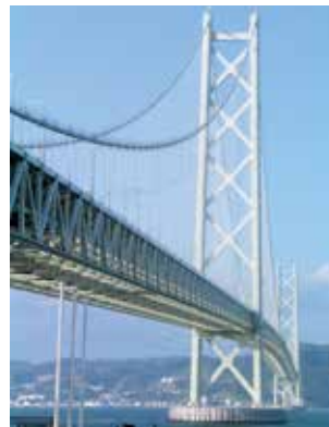
明石海峡大橋 (ハンガーケーブルに使用、 兵庫県神戸市～淡路町) AkashiKaikyo Bridge (Hyogo)
