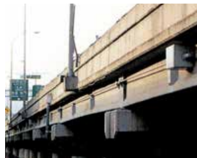
補強用外ケーブル external cables
