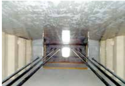
桁内外ケーブル external cables in Box girder
