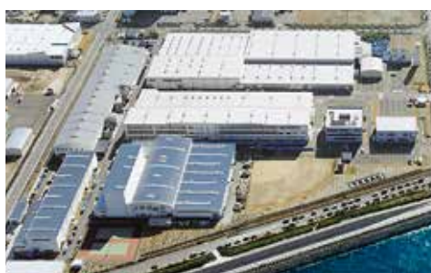
ロープ製造所 二色浜地区 Wire Rope Manufacturing Plant Nishikinohama District
