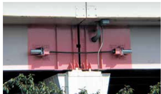
支圧型落橋防止ケーブル Bearing-type antiseismic ties for bridge
