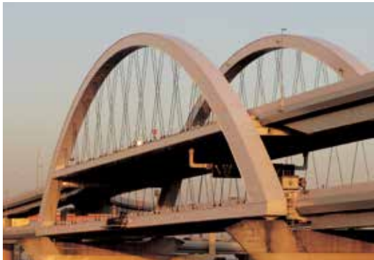
五色桜大橋(東京都足立区) Goshikizakura Bridge (Tokyo)
