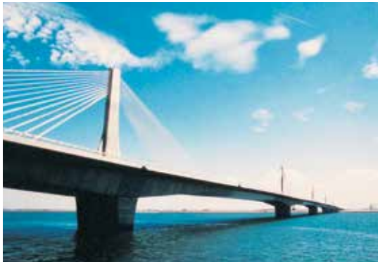
木曾川橋・揖斐川橋(三重県木曾岬町～桑名市) Kisogawa Bridge, Ibigawa Bridge (Mie)
