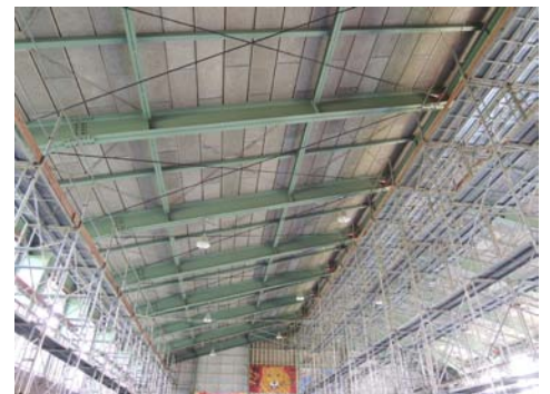
足場の設置状況(屋根、長尺配置)
