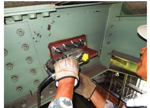
定着金具の取付(屋根)
