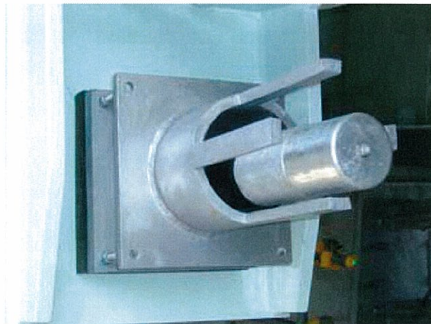
② フォークパイプの取り付け
