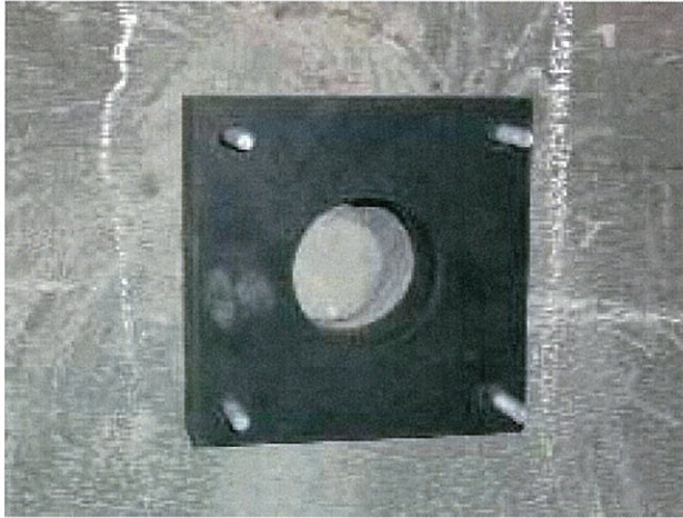
① 定着部取り付けボルト、緩衝材の取り付け
