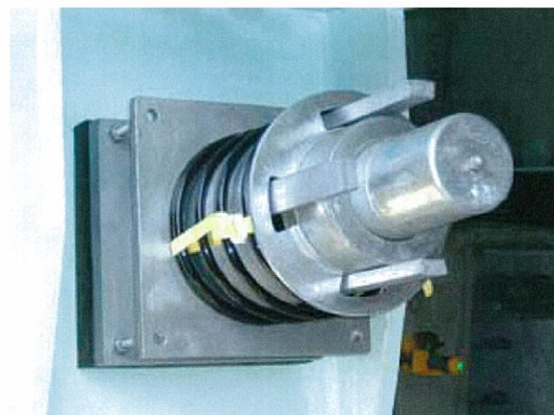
④ 定着ナットの取り付け
