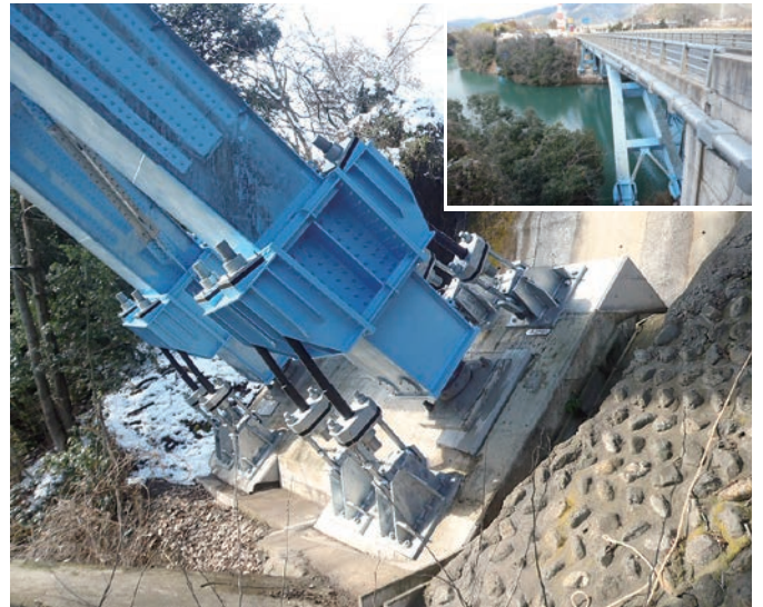
浮き上がり防止ケーブル (負反力対策)
