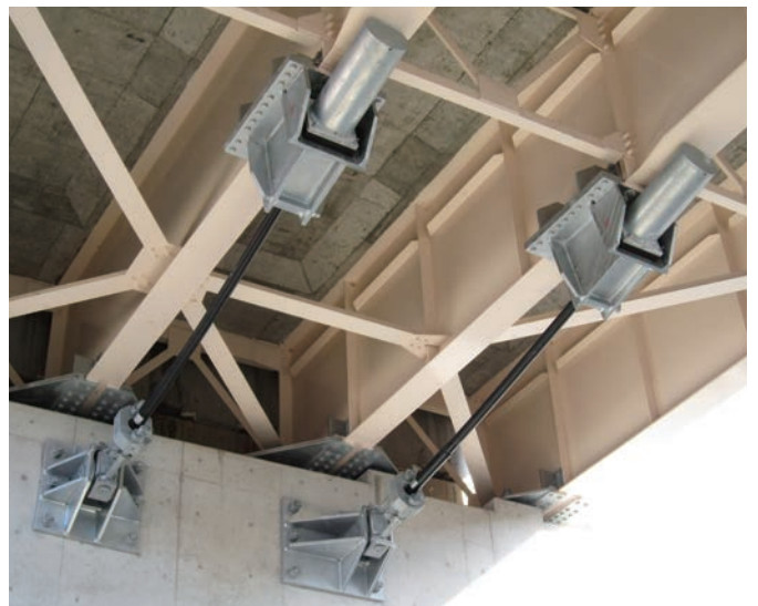
鋼製桁-下部工連結(支圧型/SPJ)
