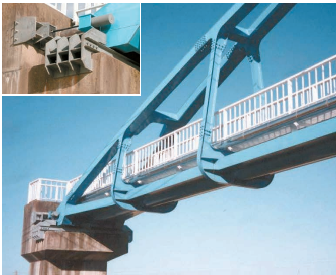
水管橋 鋼製桁-下部工連結(支圧型)
