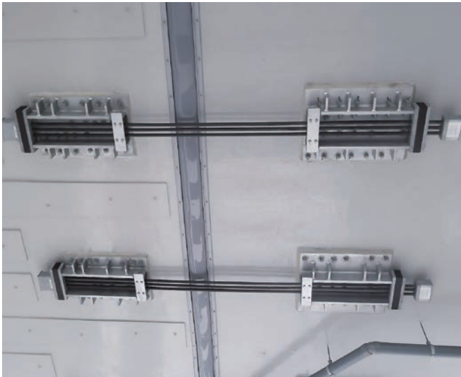
フラットケーブル
