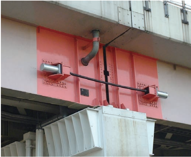
鋼製桁-鋼製桁連結(支圧型)
