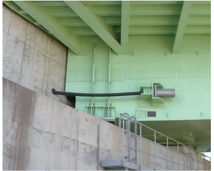
鋼製桁-下部工連結(支圧型)
