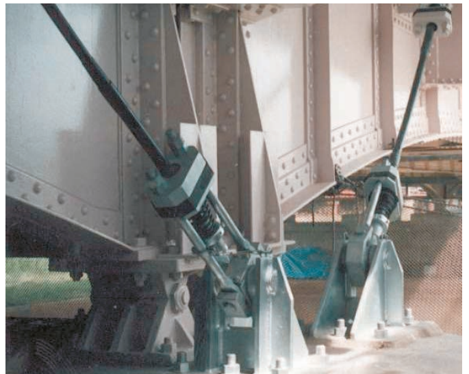
鋼製桁-下部工連結(ピン型)
