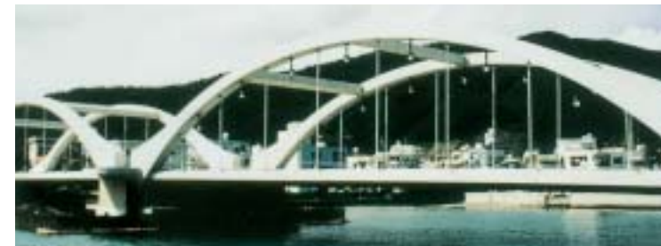
KONIYA GYOKO BRIDGE (KAGOSHIMA)
