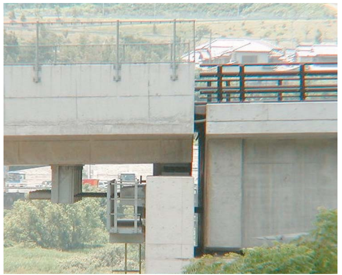
コンクリート桁～下部工連結（支圧型）
