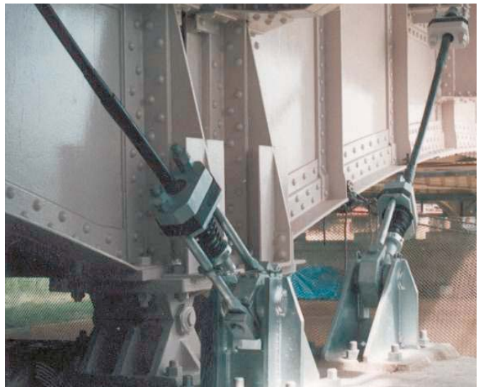
鋼製桁～下部工連結（ピン型）
