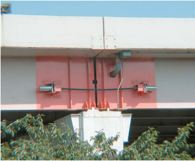
鋼製桁～鋼製桁連結（支圧型）
