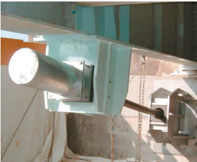
鋼製桁～下部工連結（変位制限機能付）
